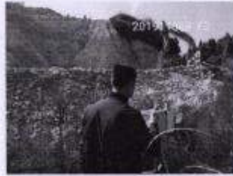
F3、项目西侧 3#监测点
